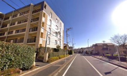
⑤戸神台西街区公園前
